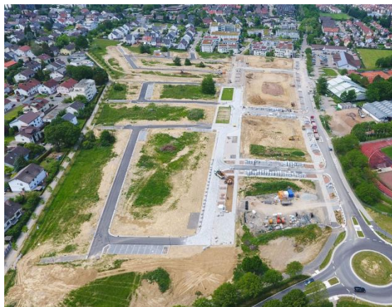
Baubeginn „Rück II“
