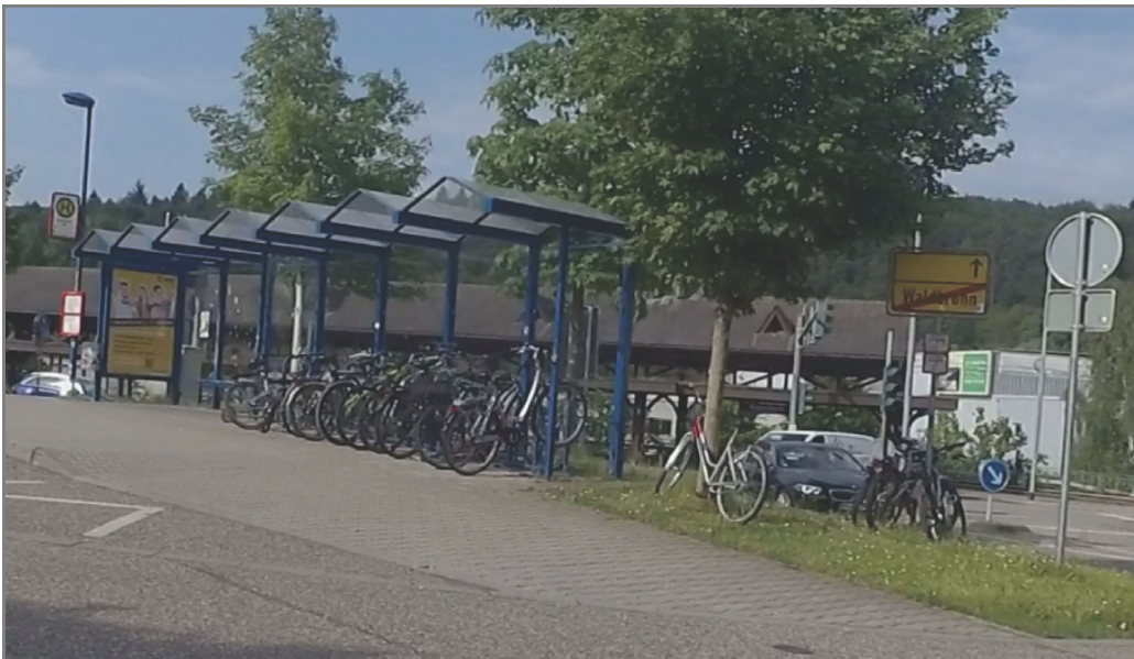
Abb. 10: Radabstellanlage Busenbach Bahnhof mit "wild" abgestellten Rädern daneben
